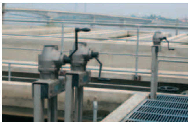
在越南污水厂，伞齿齿轮箱用于人工操作的阀门
