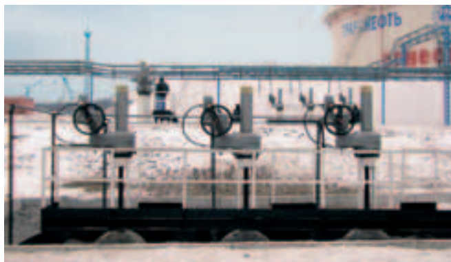
在西伯利亚，AUMA多回转执行器SA配置直齿齿轮箱。
