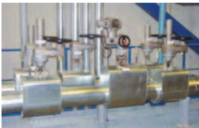
在一个热发电厂, 5个人工操作的闸阀配置了GST直齿齿轮箱和一个闸阀配置了AUMA多回转执行器
